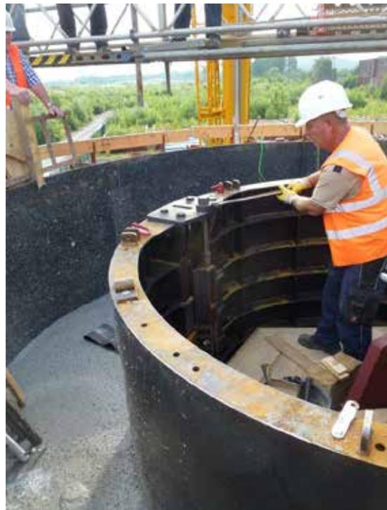
*Abb. 2: Betätigung der Spindel an der Kletterschalungsmechanik während des Betonversuchs.*
