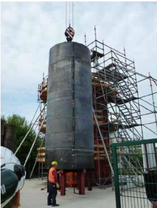
*Abb. 1: Einheben der Kletterschalung in den Schachtdummy.*
